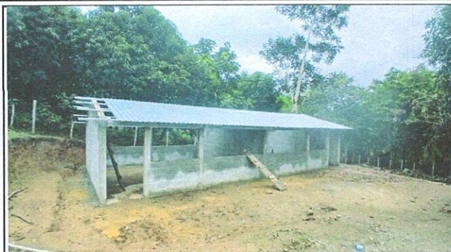
Foto 8: CUBIERTA DE LÁMINA TROQUELADA CALIBRE 26
