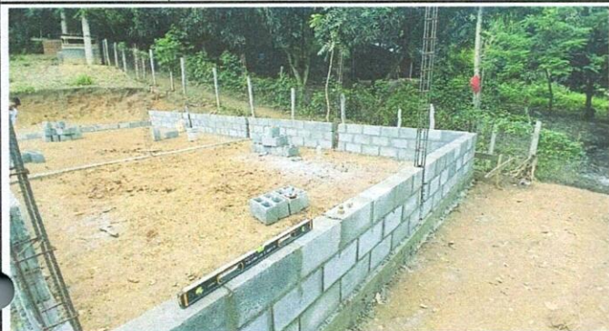
Foto 1: CIMIENTO CORRIDO CON MATERIALES DE CALIDAD
