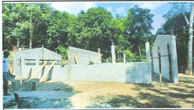
Foto 4: PAREDES CON CEMENTO Y BLOCK NORMADO
