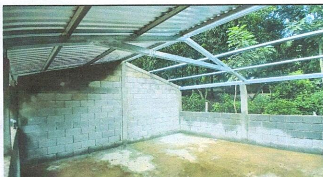
Foto 9: ESTRUCTURA DE TECHO CON COSTANERA CHAPA 16
