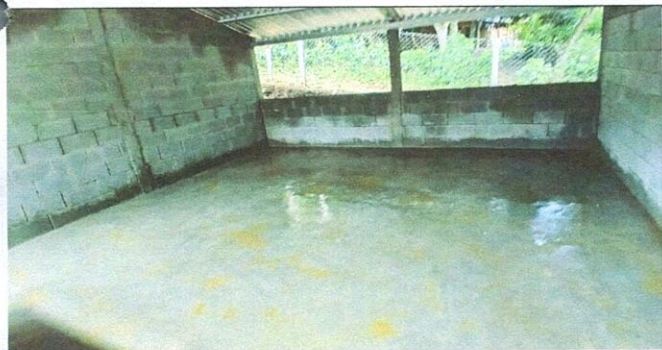
Foto 5: LOSA INTERIOR DE CEMENTO UGC.
